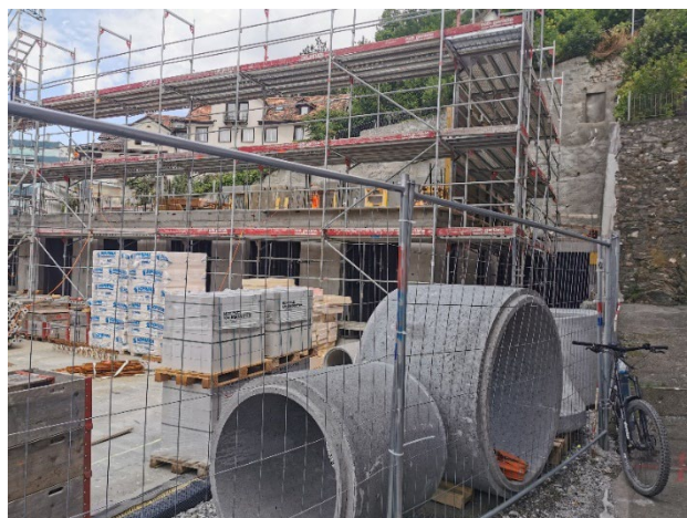
Das künftige Stadtarchiv im Erdgeschoss des Neubaus an der Steinbruchstrasse, Blick auf den Lesesaal und die Büros. Stand der Bauarbeiten am 5. Juli des Berichtsjahres (Foto Stadtarchiv Chur)
