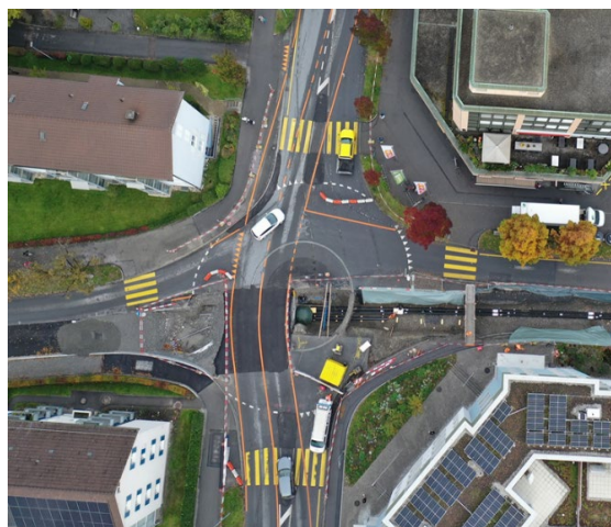
Baustelle Kreisel Ringstrasse/Tittwiesenstrasse
