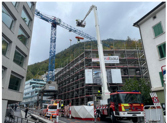
Personenrettung mit dem Hubretter von einer Baustelle
